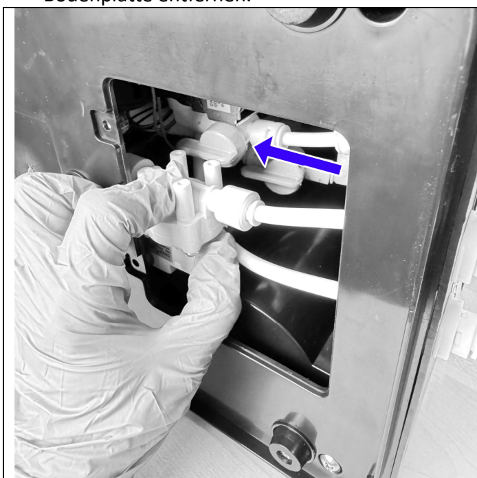
Modus Handbefüllung : Beide Ventile (blaue Griffe)
