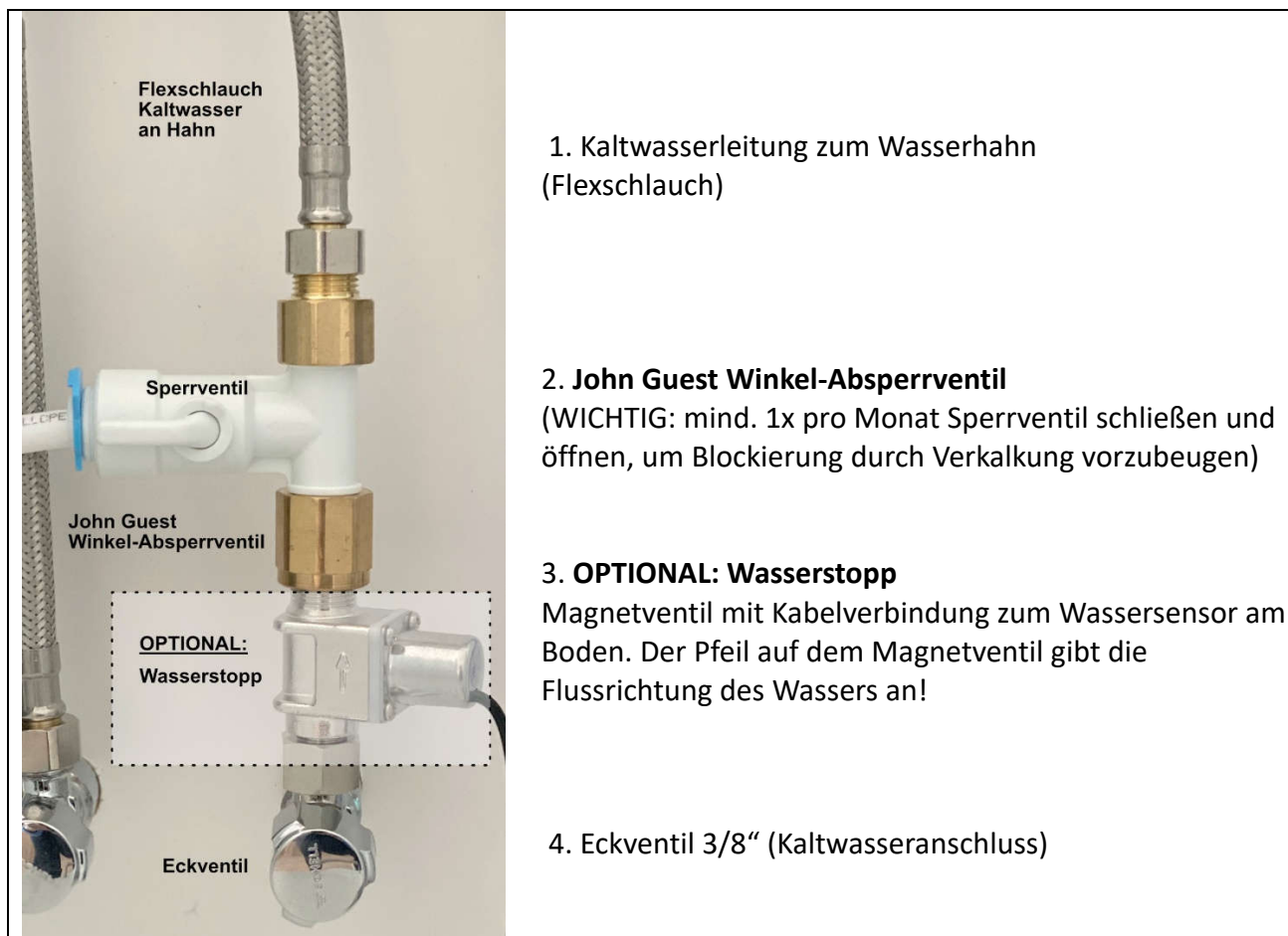
Abbildung: Kaltwasseranschluss an ein 3/8"-Eckventil
