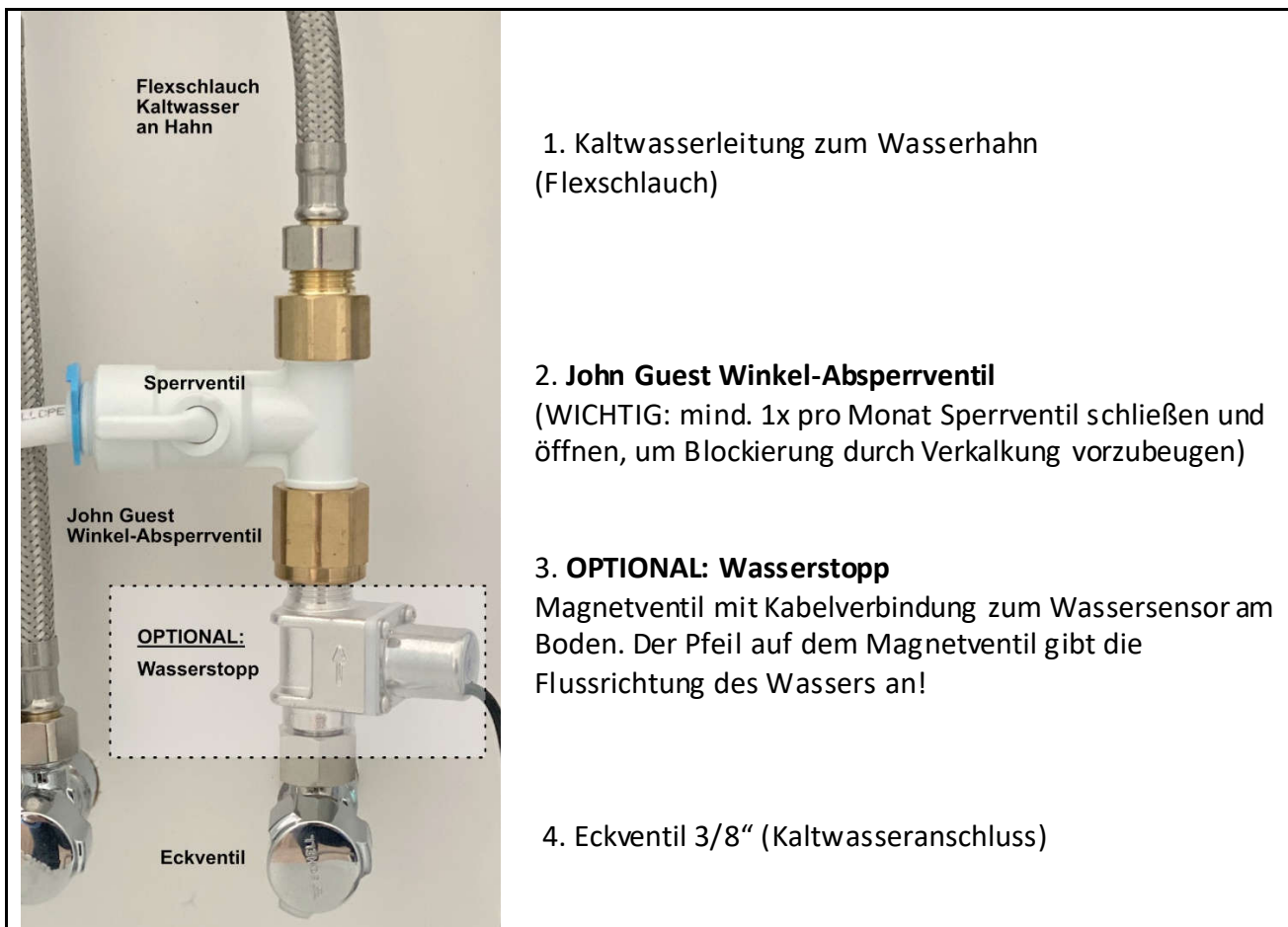
Abbildung: Kaltwasseranschluss an ein 3/8"-Eckventil
